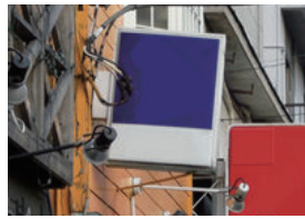
上部構造全体の傾斜、 ぐらつき
