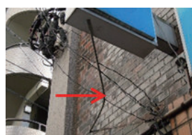
付属部材（※）の腐食、破損 ※装飾、振れ止め棒、鳥よけ、その他付属品
