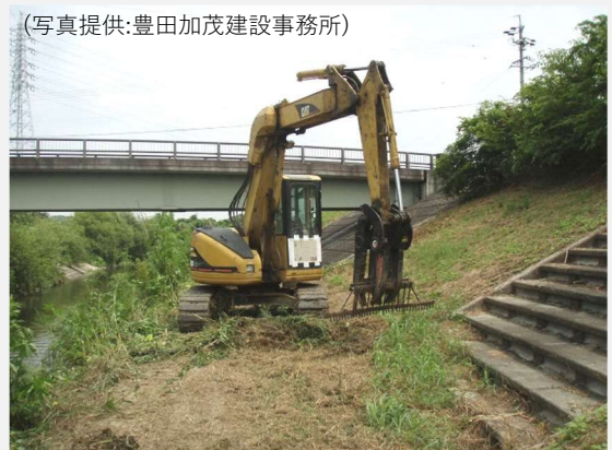
重機による除去作業
