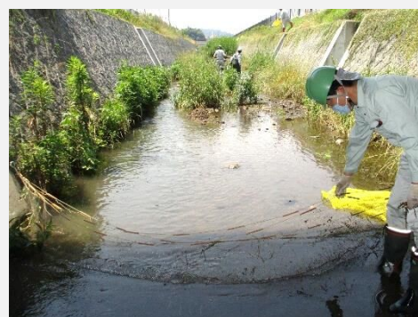
防除作業にともなう断片の流出防止のためのネット設置
