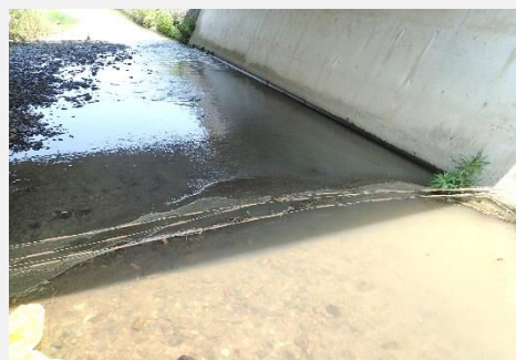
防除作業に伴う断片の 流出防止のためのネット設置
