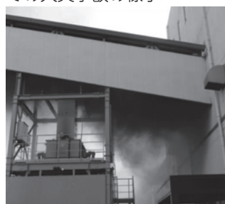
東部知多クリーンセンターでの火災事故の様子
