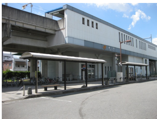
緒川駅の高架ホームと駅前広場のバス停留所
