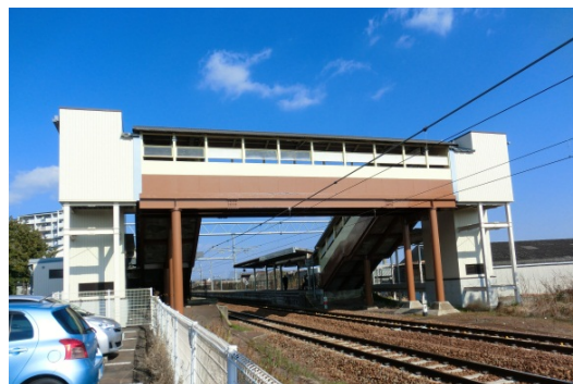
東浦駅(跨線橋とその両側にエレベーター)
