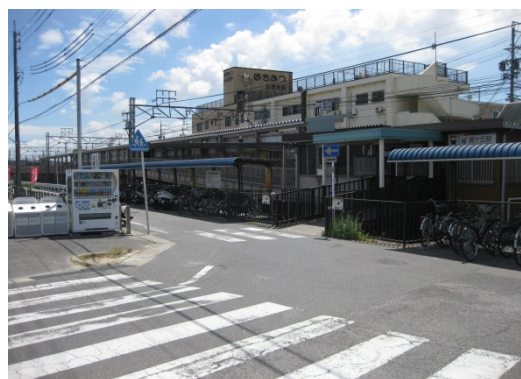
巽ヶ丘駅 東口の駅前
