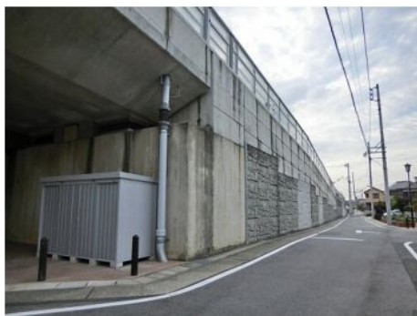
・高架下倉庫と擁壁
