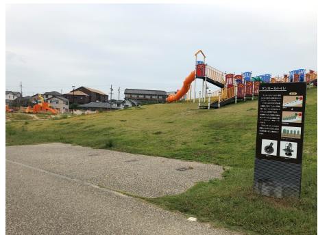
三丁公園のマンホールトイレ
