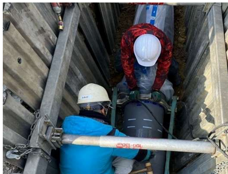
水道管の更新工事
