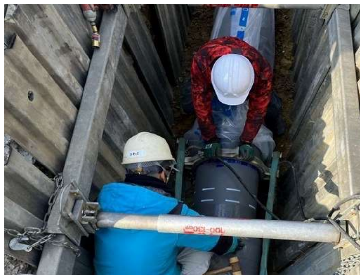
水道管の更新工事
