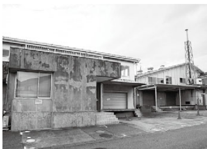
▲解体が予定されている旧学校給食センター（緒川）
