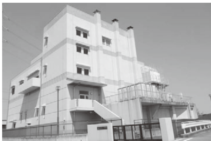
▲緒川ポンプ場
