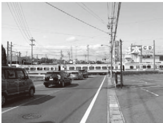
▲名鉄河和線(緒川寿久茂地内)
