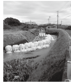
▲須賀川の河川整備
