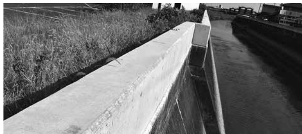
▲岡田川左岸 堤防かさ上げ(緒川字三角地内)
