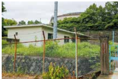
▲町水道を支える東浦第2配水池
