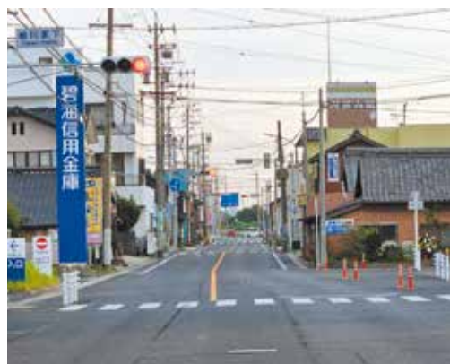
▲緒川地区366号交差点改良(一部拡幅済み)
