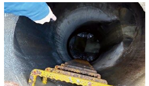
▲マンホールの内部
