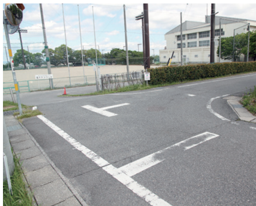
▲町道4035号線安全対策
