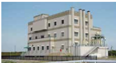
森岡ポンプ場
