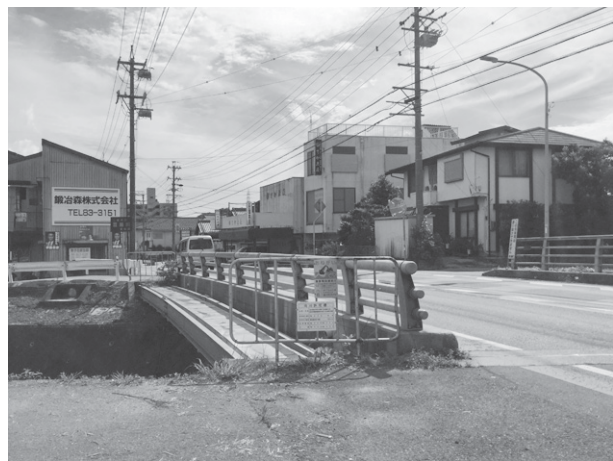
▲豆搗橋改修工事（石浜）
