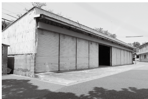
▲建て替え前の役場庁舎南倉庫
