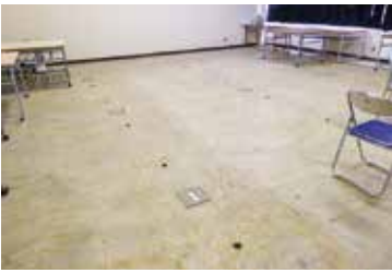
▲経年劣化によるじゅうたんの張替(北部中学校多目的室)
