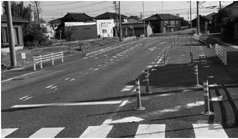
▲国道366号側からバイパス方面を臨む
