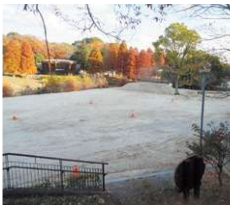
▲再整備工事が進む於大公園
