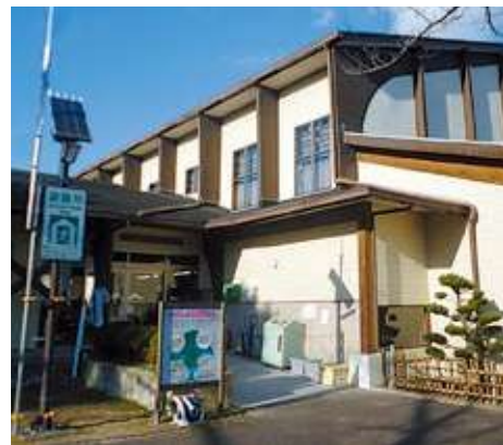
▲空調設備使用料が新設される藤江コミュニティセンター
