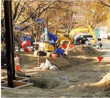
▲工事が進む於大公園
