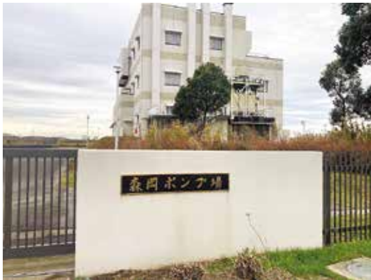
▲森岡ポンプ場
