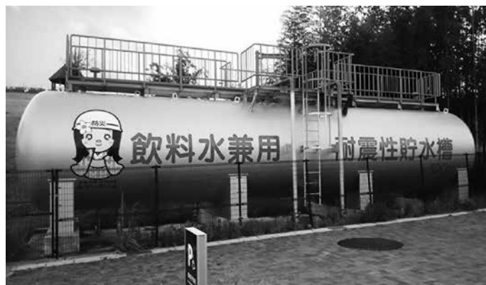
▲飲料水兼用耐震性貯水槽 (藤江三丁目公園)
