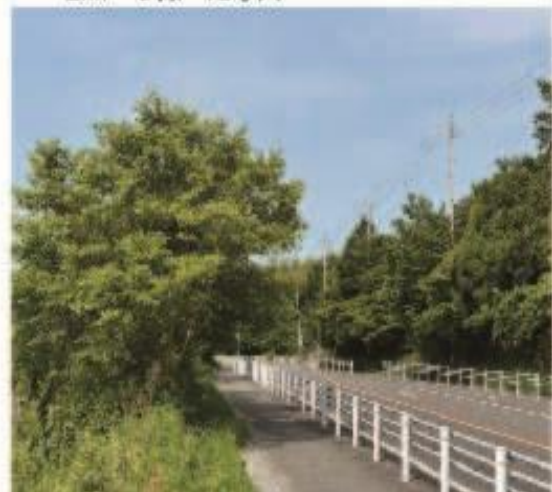
B地点から撮った写真
