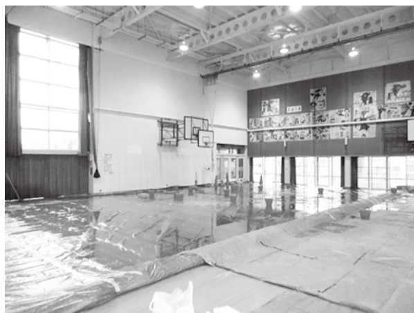
▲卯ノ里小学校屋内運動場
