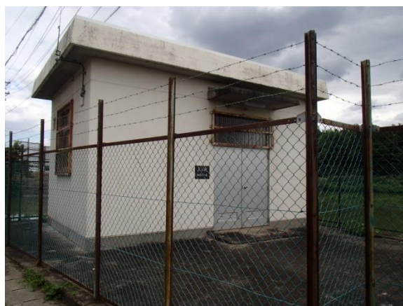
上ノ池ポンプ場
