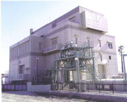
【緒川ポンプ場】
